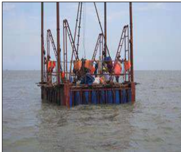
Khoan khảo sát địa chất dưới nước/ Soil investigation – Under water
