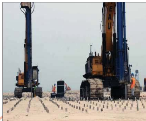
Thi công bắc thăm/ PVD Installation
