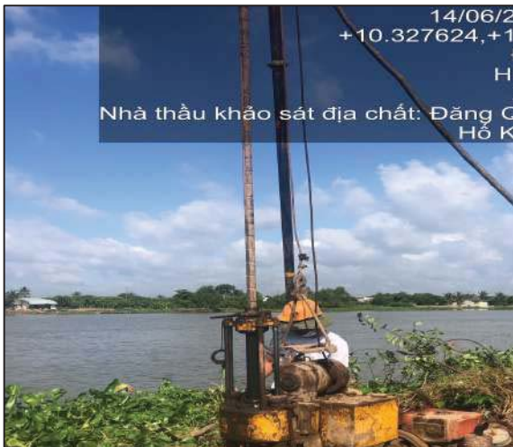
Khoan khảo sát địa chất trên cạn/ Soil investigation - On the ground
