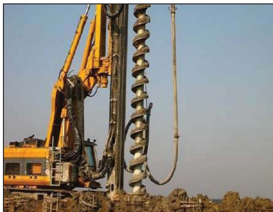
Thi công nền móng – Khoan dẫn/ Foundation works - Drilling guide
