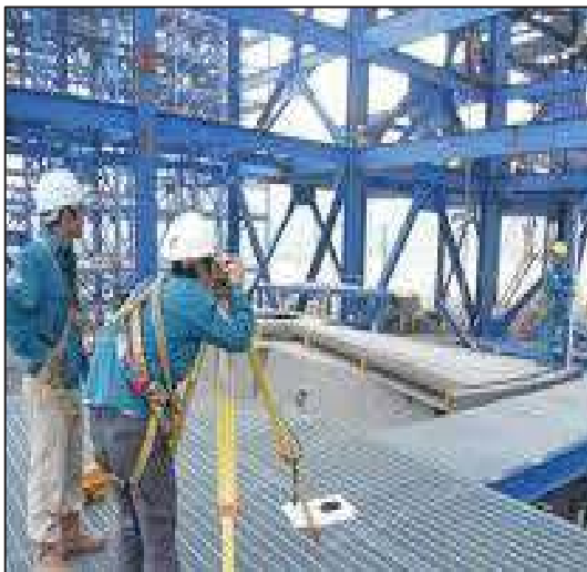
Quan trắc lún nghiêng công trình cao tầng, giao thông, nhà xưởng, mái taluy/ Monitoring settlement and inclination of high-rise buildings, traffic, factories, taluy roofs
