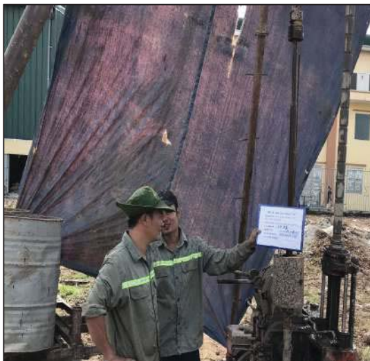
Khoan địa chất nhà máy năng lượng mặt trời, điện gió/ Soil investigation – Solar and Wind Energy
