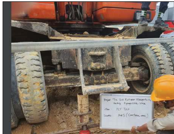
Thí nghiệm bàn nén hiện trường xác định sức chịu tải của đất nền./ Field compression table test to determine the bearing capacity of the ground.
