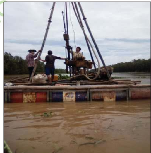
Khảo sát địa chất các công trình cầu, cảng biển/ Soil investigation – Bridge, seaport
