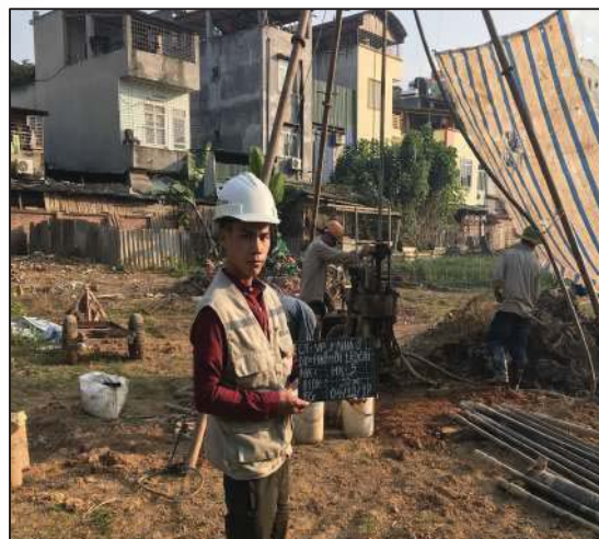
Khảo sát địa chất các công trình chung cư, cao tầng / Soil investigation – Building
