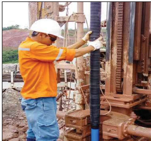
Quan trắc áp lực nước lỗ rỗng Piezometer/ Piezometer pore water pressure monitoring
