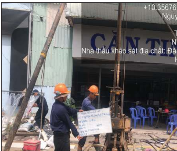
Khảo sát địa chất các công trình nhà xưởng/ Soil investigation – Factory, industrial zone
